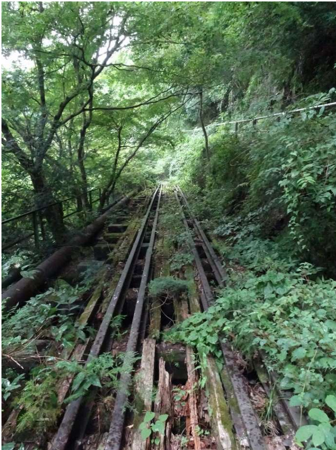
奥多摩むかし道と交差すぐ脇、水根駅側の第一弁天橋梁 廃線跡を見下ろしながら石畳のむかし道を進める。
