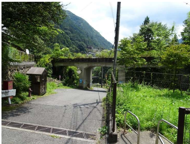
日原川橋梁 氷川駅側
