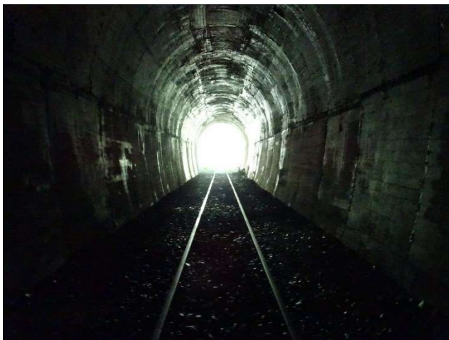
最長 467.3mの中山トンネル内部から水根側を望む トンネルは一時期奥多摩むかし道に組込まれていた
