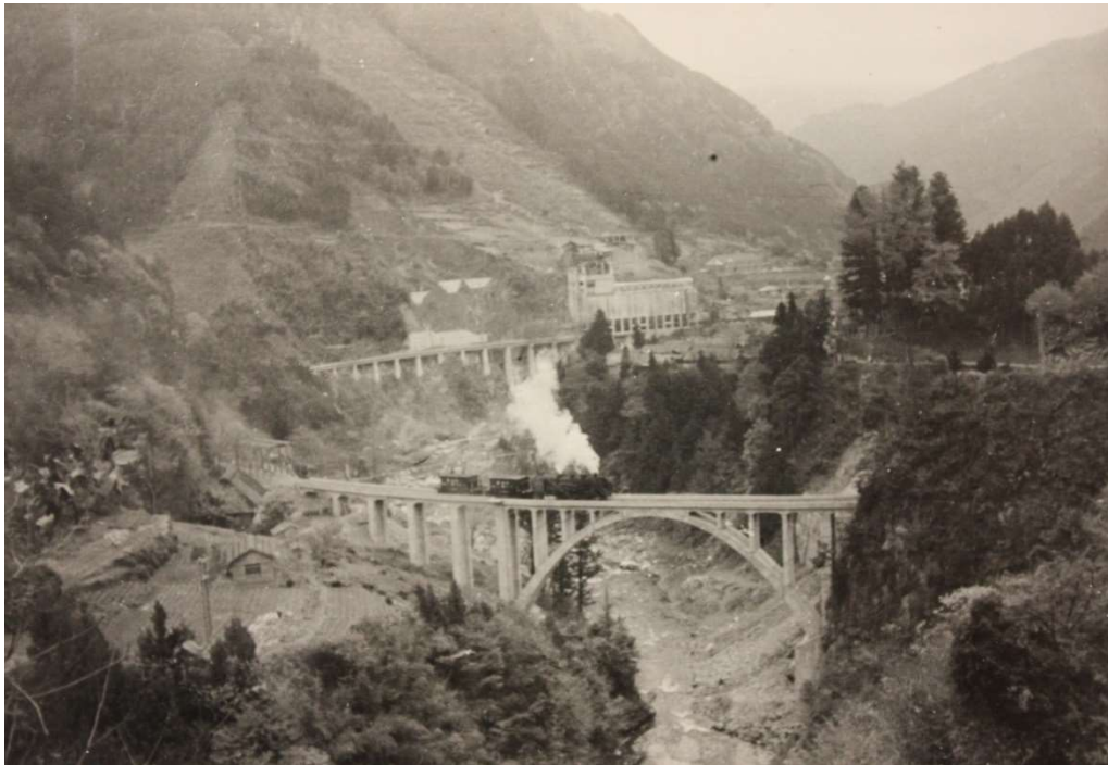
小河内線 最大の見所 日原川橋梁 緩やかなカーブの全長 100.1mのコンクリートアーチ橋 奥には最長 200.12mの第一氷川橋梁と奥多摩工業とが見られる。✕
