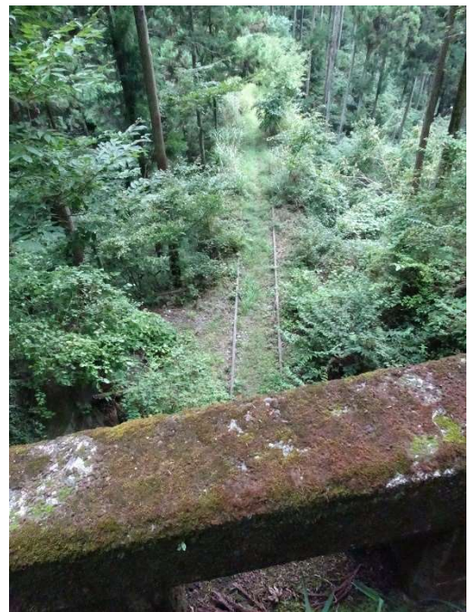
むかし道第四氷川トンネル上から第三氷川橋梁を
