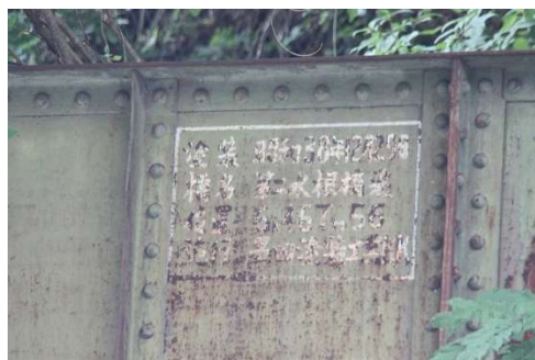
第二水根橋梁
