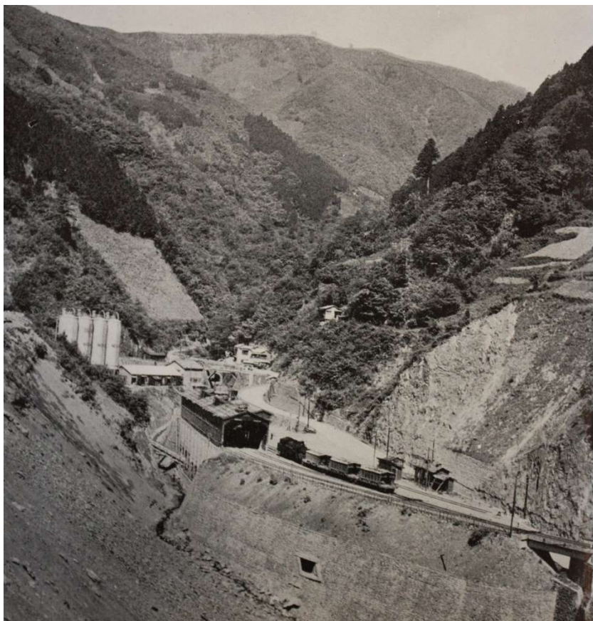
沢地を埋め立てて設置された水根駅 線路3線配置※
