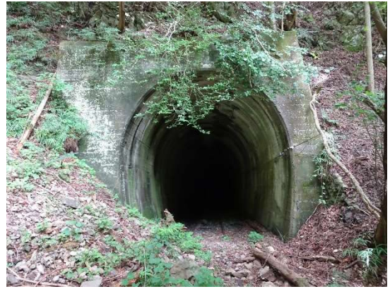
第二桃ヶ澤トンネル 中山バス停から登れば、 中山トンネルと第二桃ヶ澤隧道の間に
