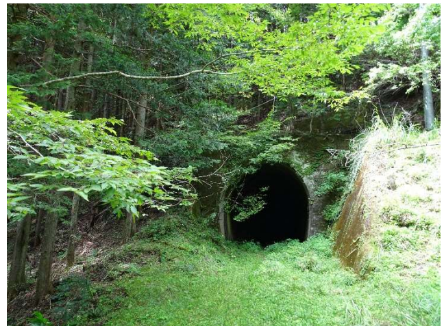
中山トンネル 氷川側
