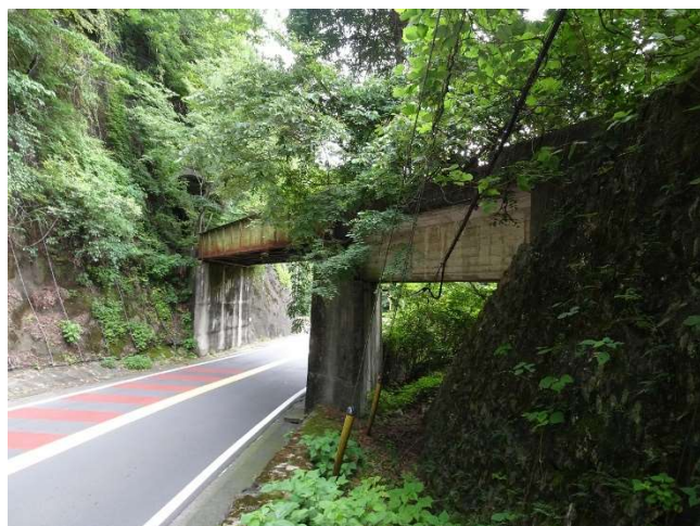
青梅街道を跨ぐ第二水根橋梁と水根トンネル
