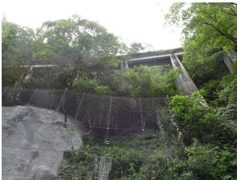
白髭橋梁 奥多摩むかし道、青梅街道（梅久保バス停近く）から見上げられる巨大なコンクリート橋
